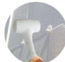
4-Battere sullo spinotto per ottenere l'espansione
