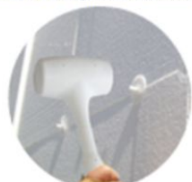
4-Battere sullo spinotto per ottenere l'espansione
